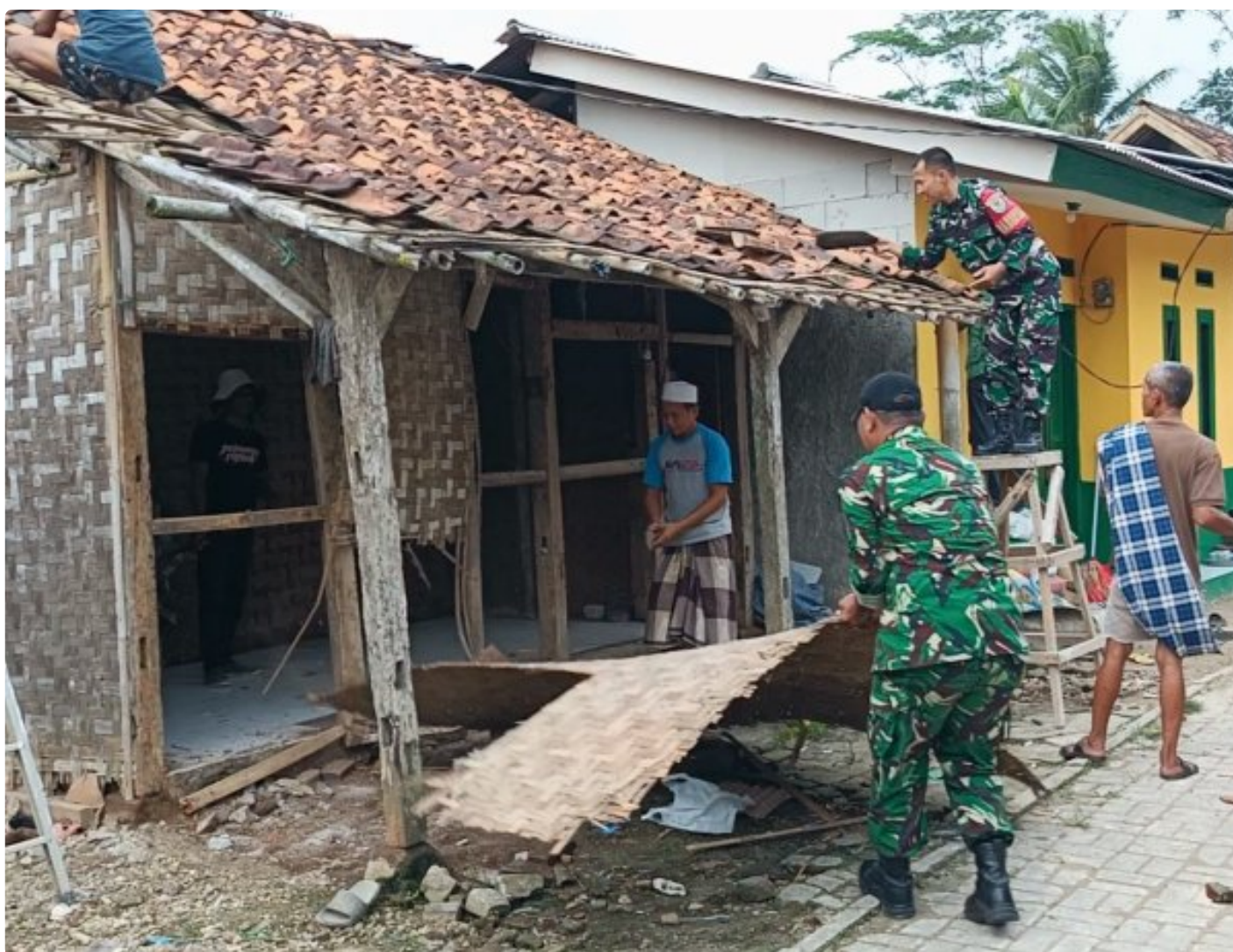
Pembongkaran Rumah Bapak Narmin
